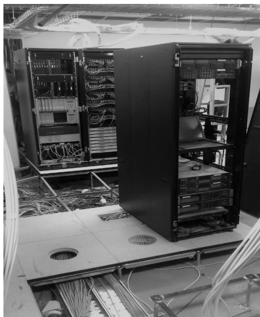
SLIKA 11 – RADOVI NA REKONSTRUKCIJI DDC BEOGRAD
